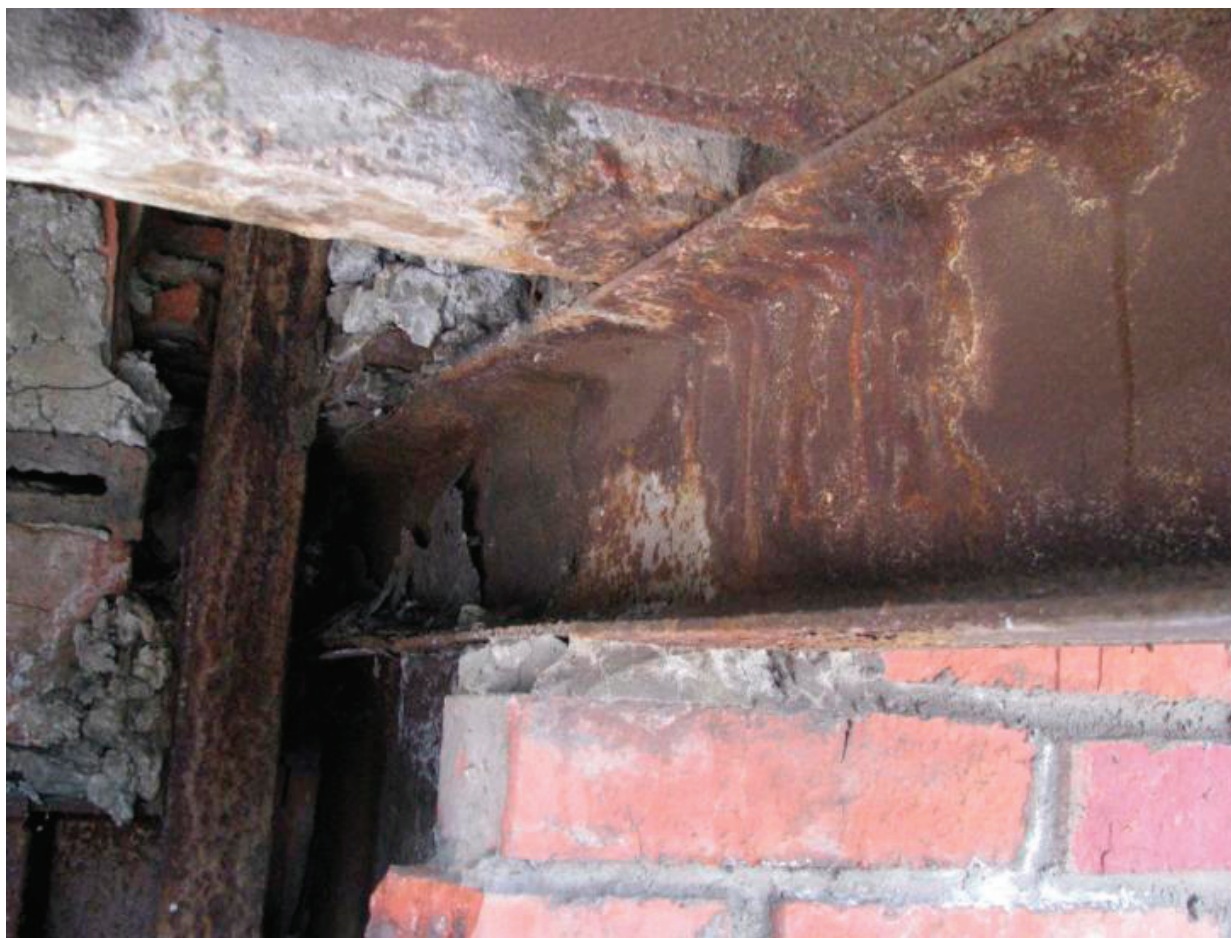
Рис. 2. Фрагмент стальной балки в зоне вскрытия огнезащитного покрытия
