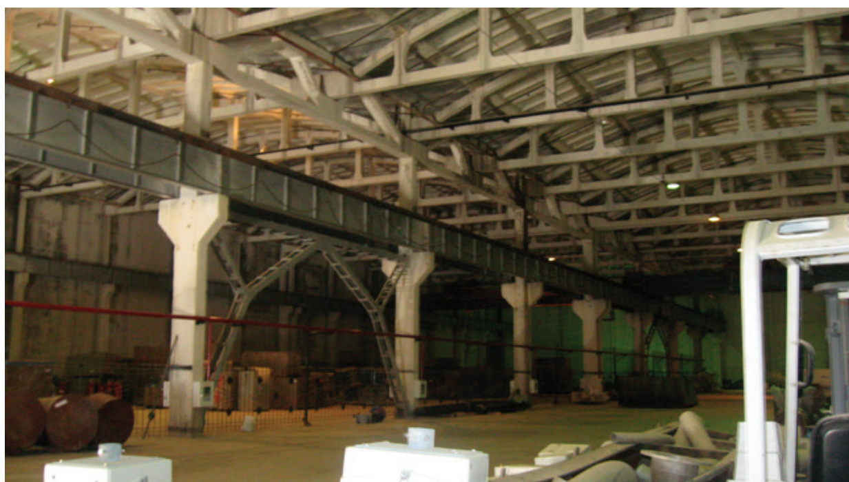
Рис. 2. Проведение геодезических обследований строительных конструкций
