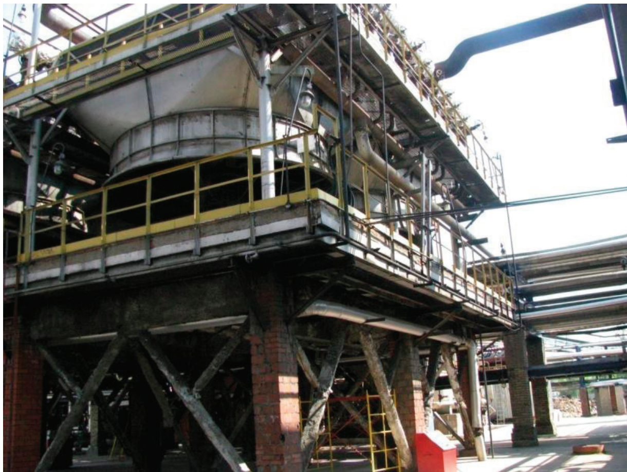
Рис. 1. Общий вид объекта
