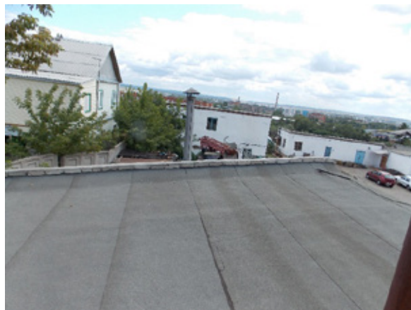
Рис. 9. Общий вид кровли (Кат В.)
