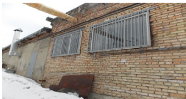
Рис. 5. Отсутствует организованный водосток
