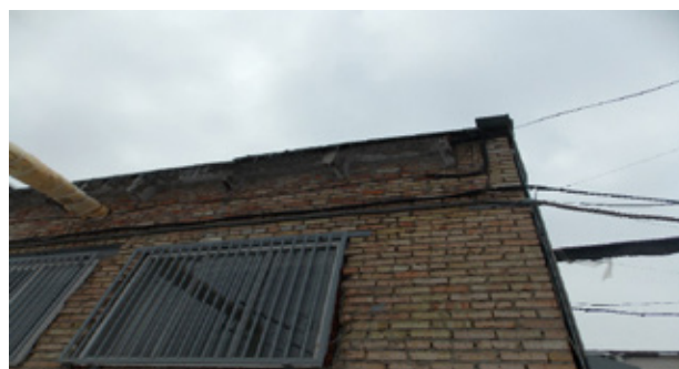
Рис. 5. Отсутствует организованный водосток
