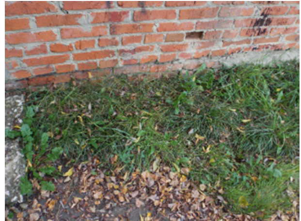
Рис. 1. Мелкие трещины в цоколе и под окнами, наличие сорных трав в районе отмостки
