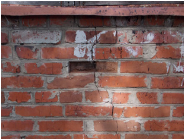
Рис. 1. Мелкие трещины в цоколе и под окнами, наличие сорных трав в районе отмостки
