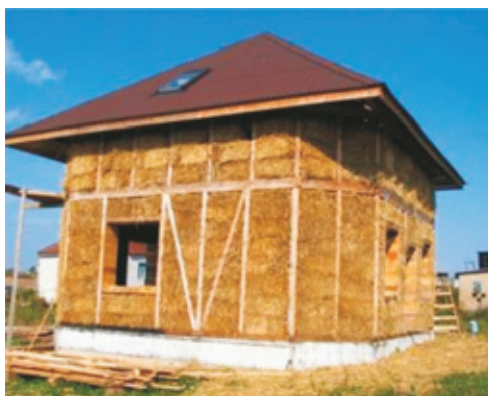
Рис. 1. Каркасный дом с применением экологически чистого органического утеплителя
