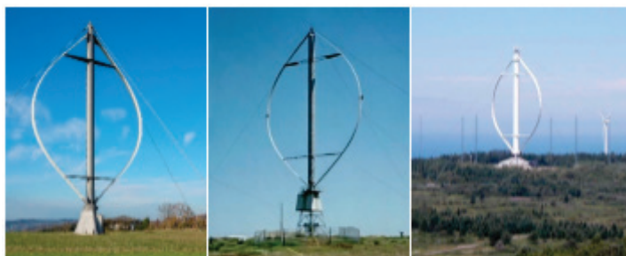
Рис. 4. Ветроустановка с ротором Дарье
