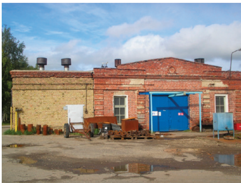
Рис. 1. Общий вид здания механических мастерских
