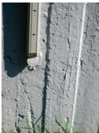
Рис. 1. Репер на железобетонной стойке технологической эстакады
