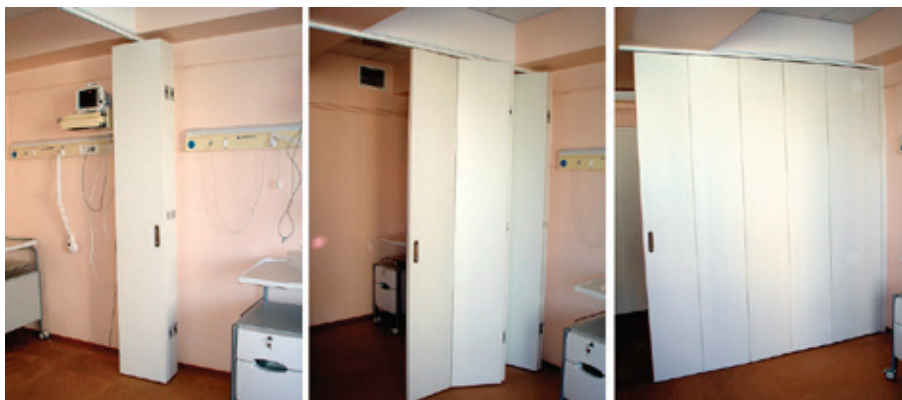
Рис. 2. Пример использования трансформируемых перегородок
