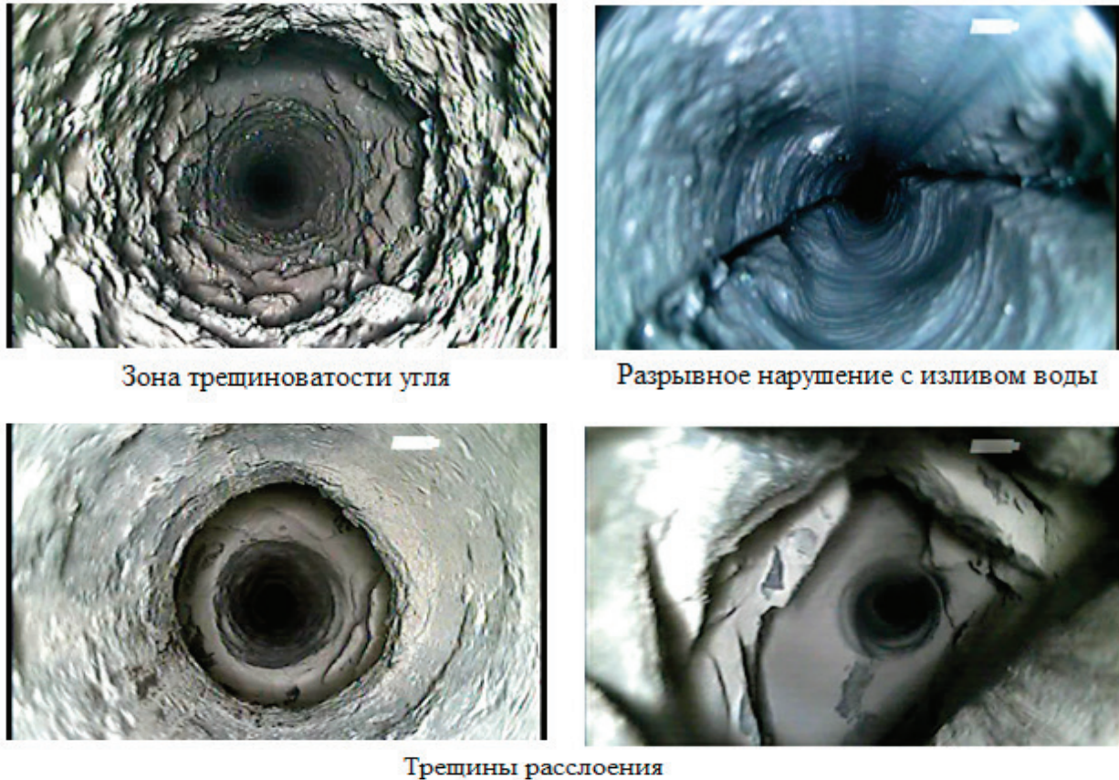
Рис. 3. Разновидности трещин, выявленные с применением видеоэндоскопа
