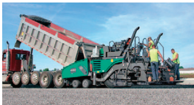
Рис. 3. Перегружатели асфальтобетонной смеси
