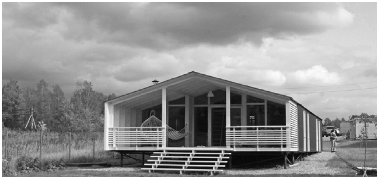
Рис. 1. Вариант модульного быстровозводимого здания DUBLDOM (Россия)
