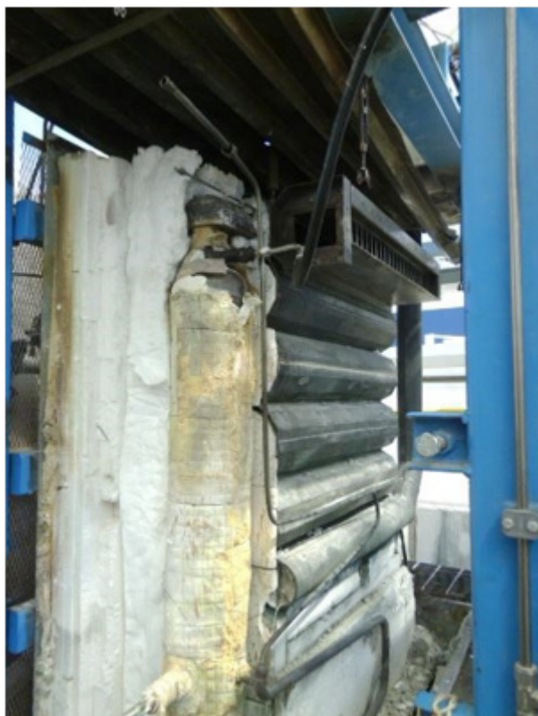
Рис. 1. Общий вид трубопровода
