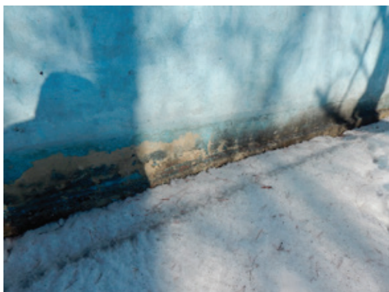
Рис. 3. Разрушение штукатурного слоя и отслоение лакокрасочного покрытия (Категория В)
