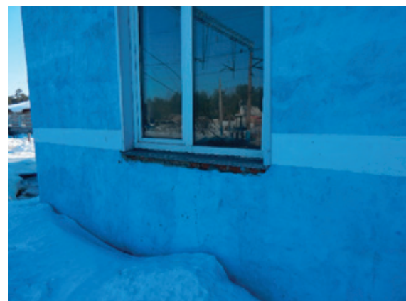
Рис. 3. Разрушение штукатурного слоя и отслоение лакокрасочного покрытия (Категория В)
