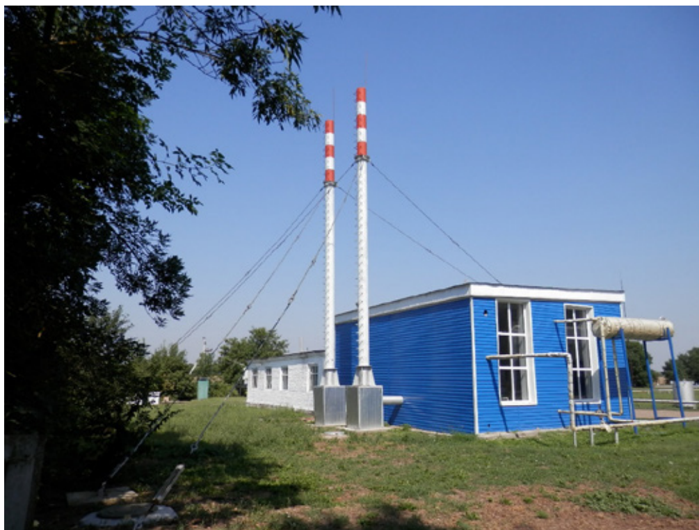
Рис. 1. Общий вид дымовой трубы
