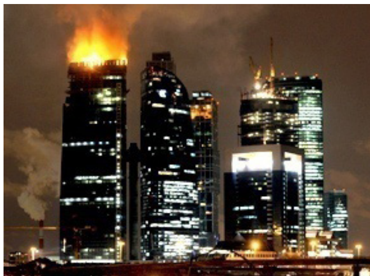
Рис. 1. Пожар на строящейся Восточной башне комплекса «Федерация». Москва-Сити, 2012 год
