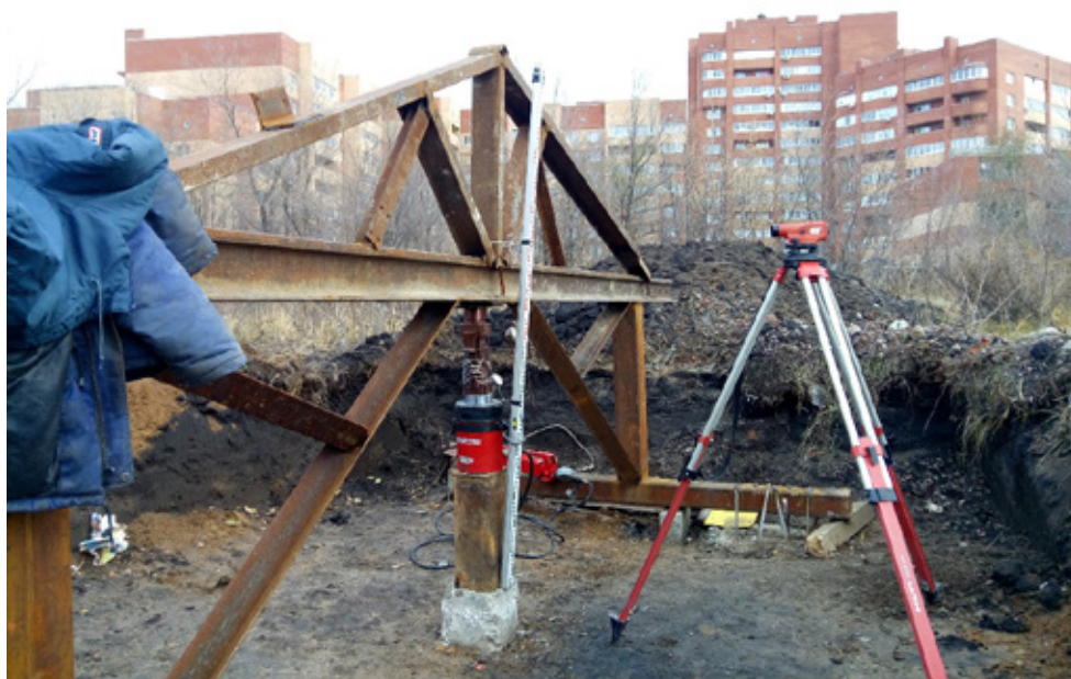
Рис. 5. Испытание одиночной буровой сваи на вдавливающую нагрузку
