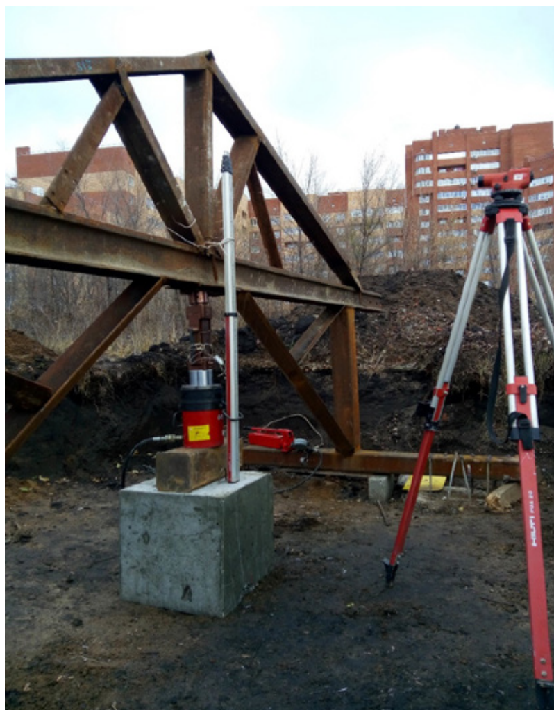
Рис. 6. Испытание односвайно-плитного фундамента
