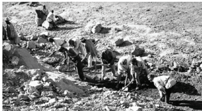
Рис. 4. Рытье котлована под озеро комсомольцами
