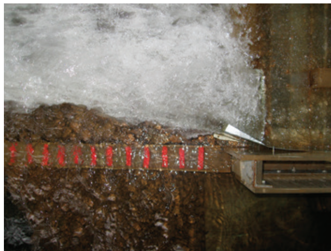
Рис. 5. Общий вид потока на выходе из водосброса № 2 с использованием отклонителя, и началом пропуска расходов с первого пролёта относительно оси турбинных камер
