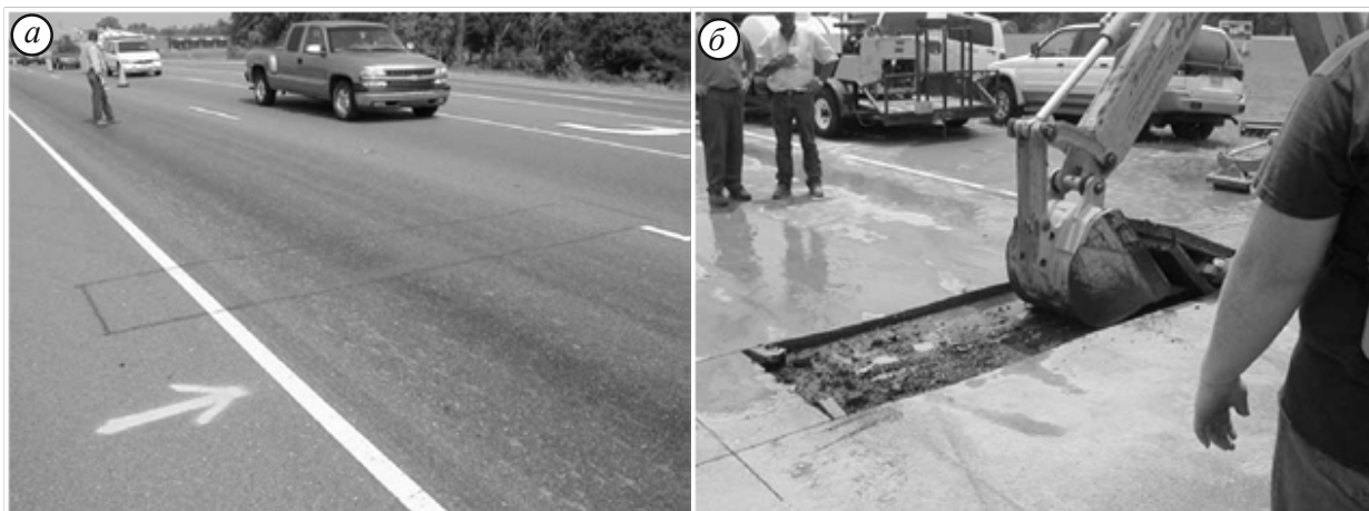
Рис. 1. Шурфирование дорожной одежды автодороги SH 302, (восток штата Миссисипи): а — разметка траншеи, б — разработка шурфа
