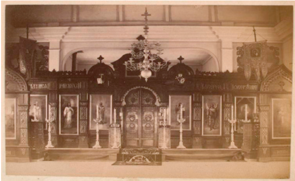
Рис. 3. Церковь селения Рыковского
