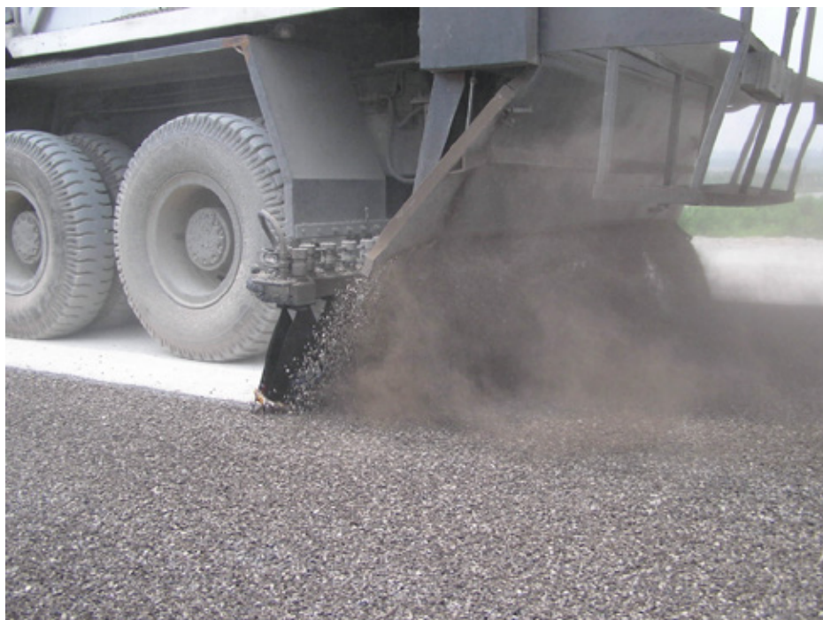
Рис. 1. Рабочий момент устройства поверхностной обработки с синхронным распределением вяжущего и щебня
