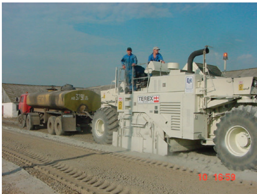
Рис. 1. Укрепление грунтов минеральным вяжущим при его распределении перед ресайклером-стабилизатором
