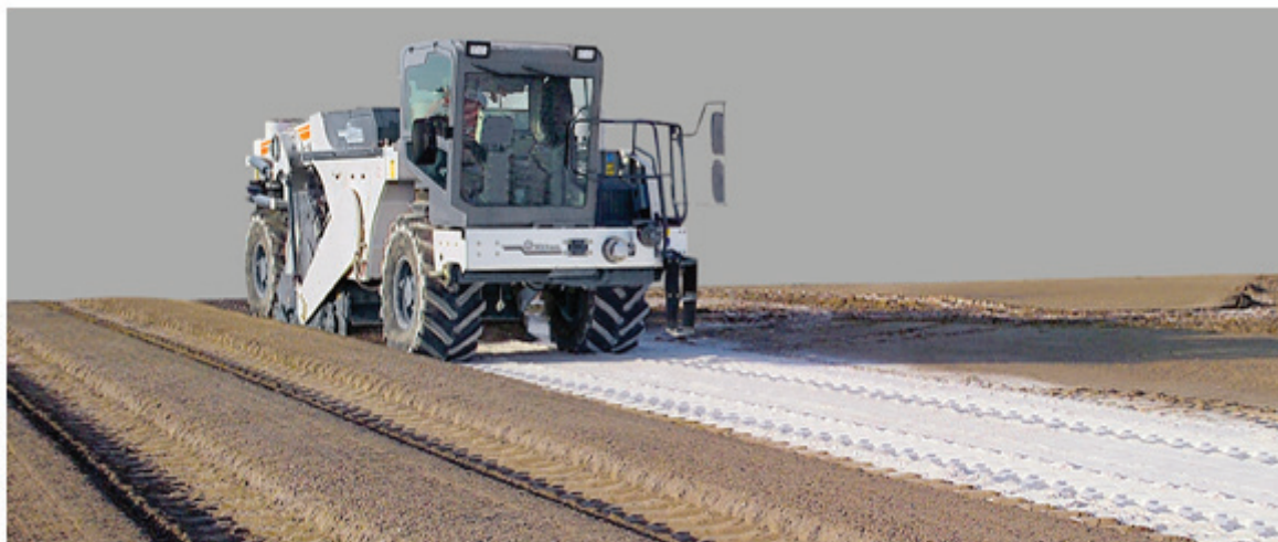
Рис. 1. Порошкообразное минеральное вяжущее, распределенное перед ресайклером-стабилизатором
