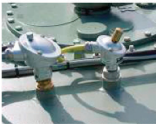
Рис. 2. Температурный датчик для измерения масла в баке
