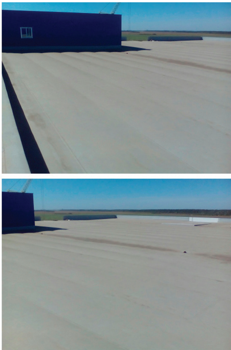
Рис. 1. Натяжение ПВХ-мембраны при действии отрицательного ветрового давления
