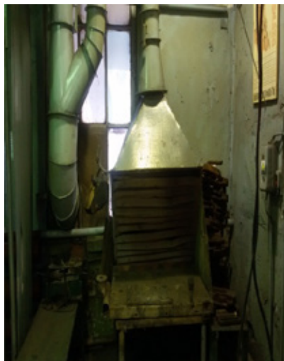
Рис. 1. Рабочее место электрогазосварщика
