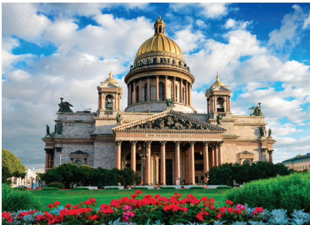
Рис. 8. Исаакиевский собор в Петербурге. Архитектор О. Монферран
