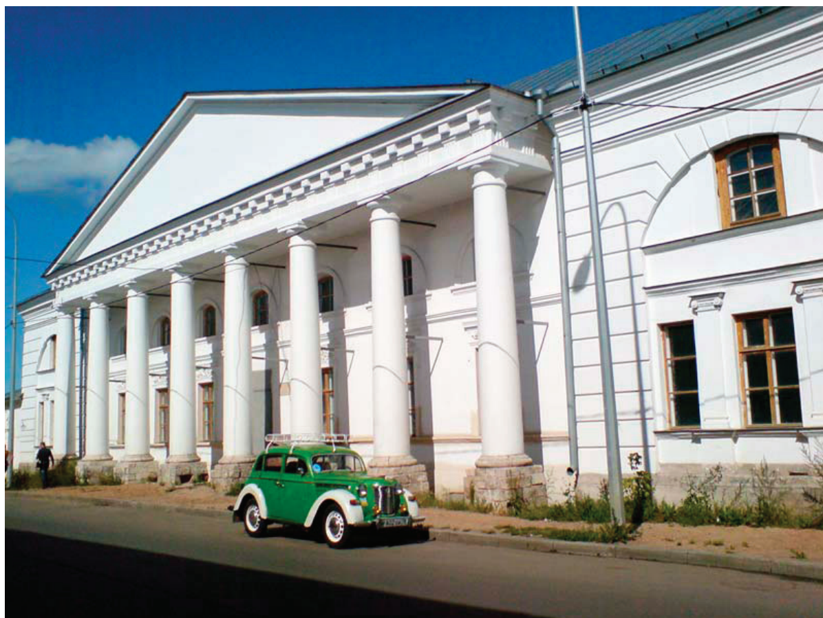
Рис. 3. Здание старой хлебной Биржи в Рыбинске. Архитектор Г. В. Петров
