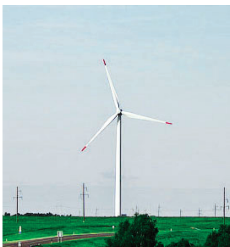
Рис. 1. Ветроэнергетическая установка с горизонтальной осью вращения
