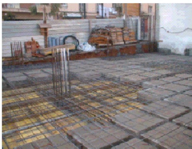
Рис. 3. Сборно-монолитное перекрытие кессонного типа
