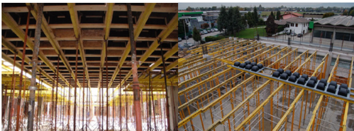
Рис. 2. Кессонная опалубка типа «Skydome»
