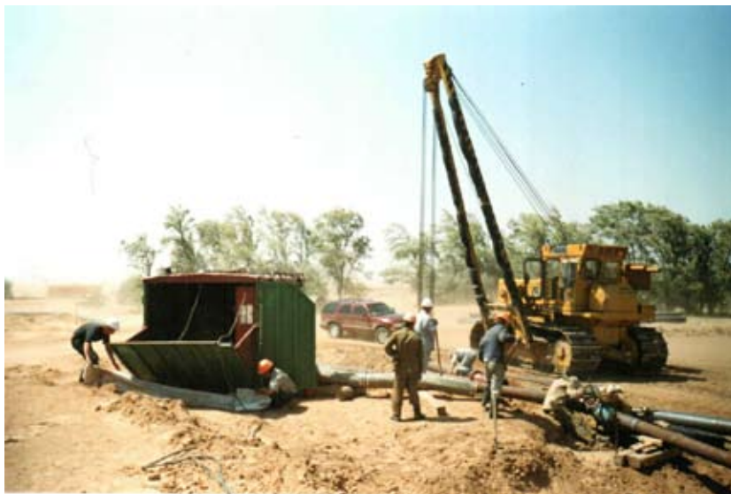
Рис. 2. У КП-5 подготавливается к запуску в районе Черноземельского канала, Республика Калмыкия. Экипаж установки защищает от пыли входное устройство.
