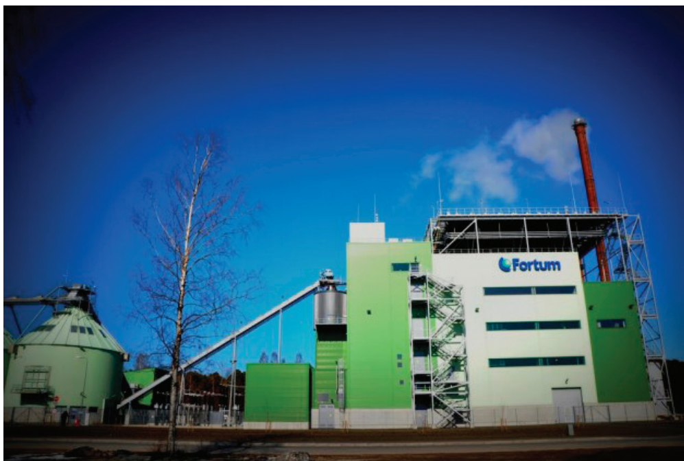
Рис. 1. Теплоэлектростанция компании Fortum в Стокгольме
