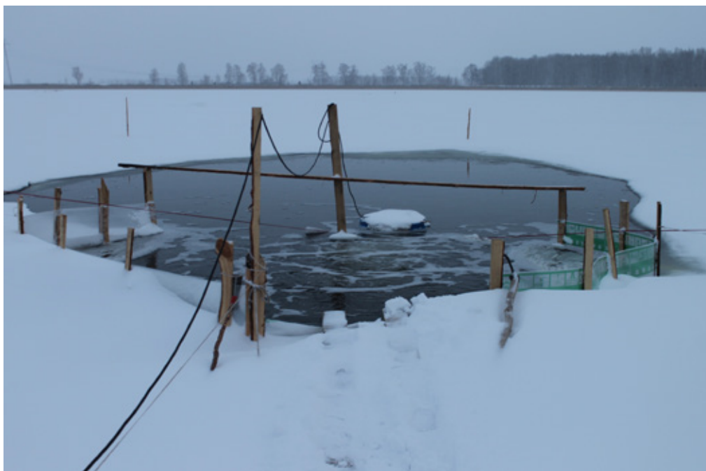
Рис. 3. Модернизированный отражатель потока на оз. Сред. Песьяново
