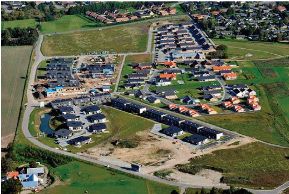
Рис. 1. Датский поселок Стенлесе Юг—результат проекта строительства экспериментального энергоэффективного поселения, ставшего крупнейшим в Европе [4]
