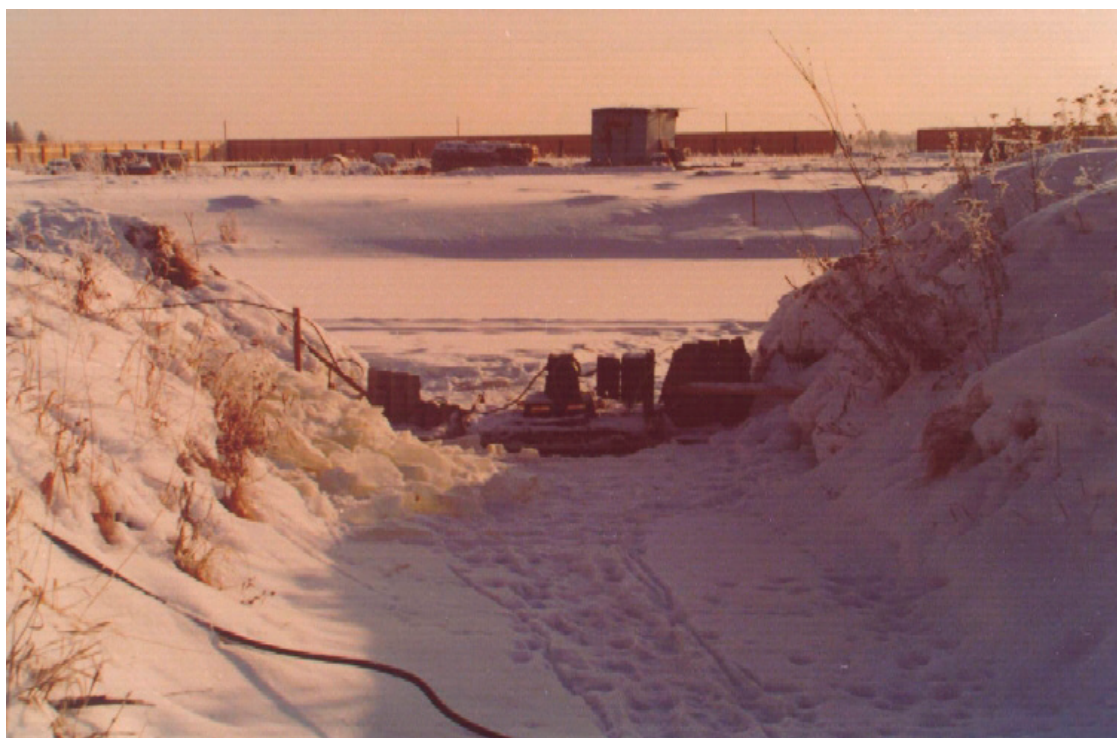
Рис. 1. Турбоаэратор Н19-ИАК/1, установленный в водозаборном канале водоема-спутника
