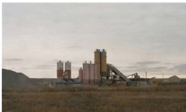
Рис. 3. Переносной цементобетонный завод
