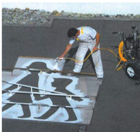
Рис. 1. Нанесение дорожной разметки
