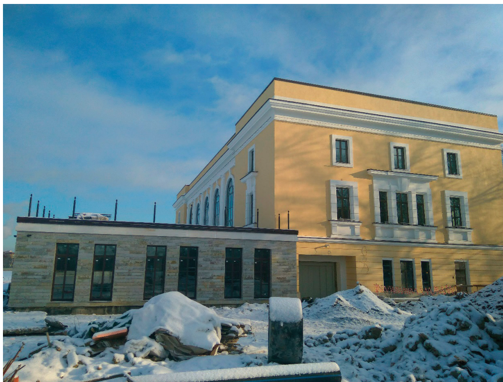
Рис. 3. «Ресторан Кюба» после реконструкции и приспособления
