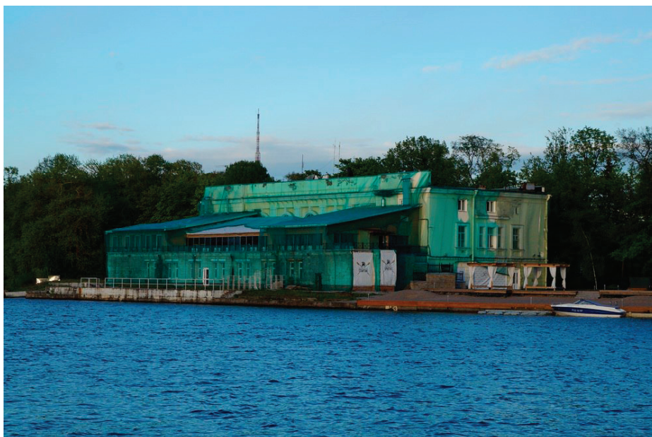
Рис. 1. «Ресторан Кюба» до реконструкции
