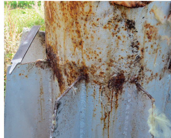
Рис. 2. Дефекты металлической трубы
