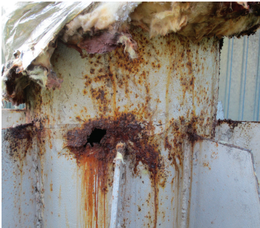
Рис. 2. Дефекты металлической трубы
