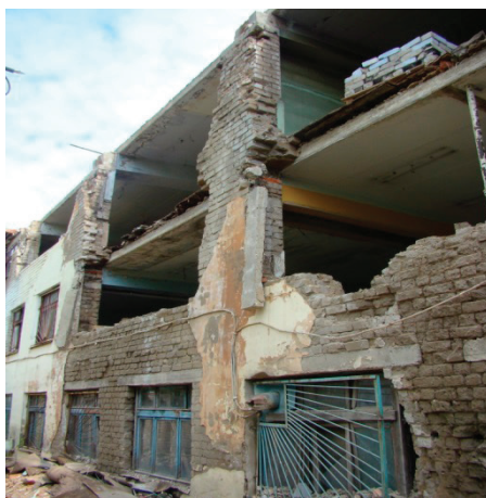
Рис. 1. Материалы фотофиксации: здание бывшего механосборочного цеха завода «Точприбор»
