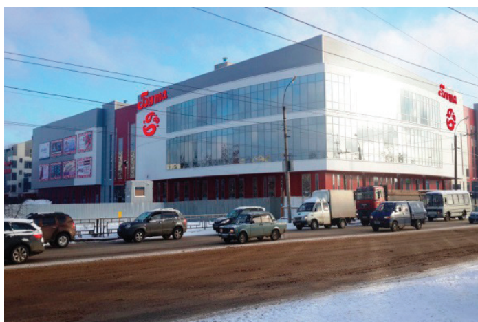
Рис. 2. Материалы фотофиксации: Центр оптово-розничной торговли после реконструкции
