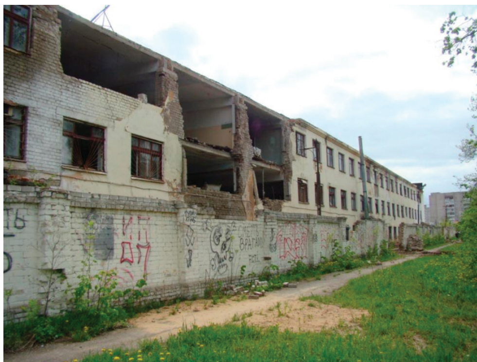
Рис. 2. Общий вид здания бывшего механосборочного цеха завода «Точприбор»
