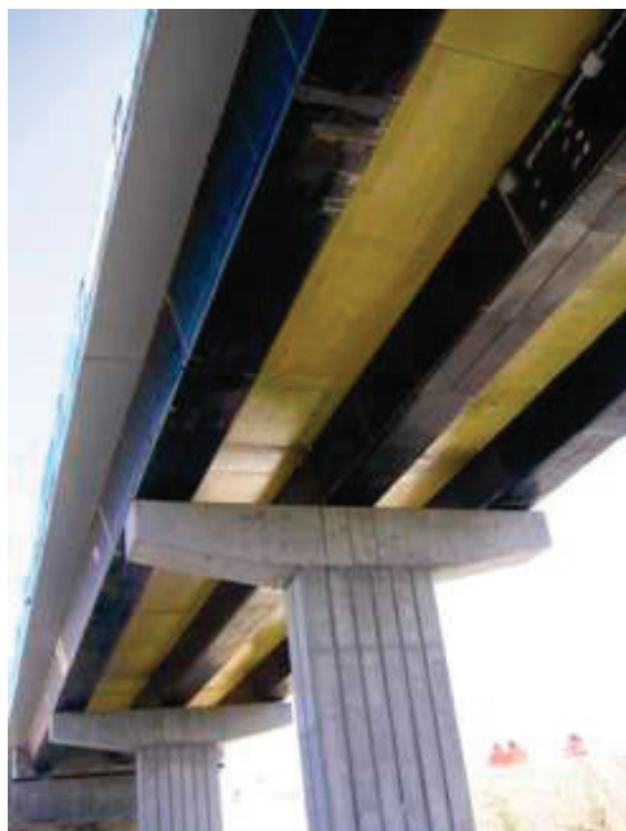
Рис. 2. Усиление с помощью композитных материалов
