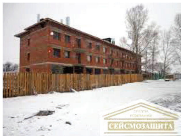
Рис. 3. Строительство жилья для персонала. Зима 2017 г.
