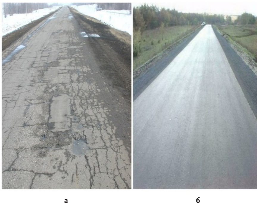
Рис. 5. Применение метода холодного ресайклинга для автомобильной дороги «Р-258 «Байкал» Иркутск — Улан-Удэ — Чита».
