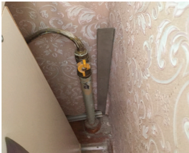
Рис. 2. Расстояние от пола до запорной арматуры 0,6 м
