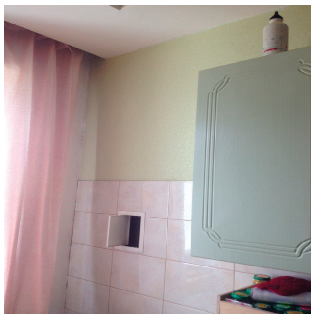
Рис. 1. Нет доступа к газопроводу
