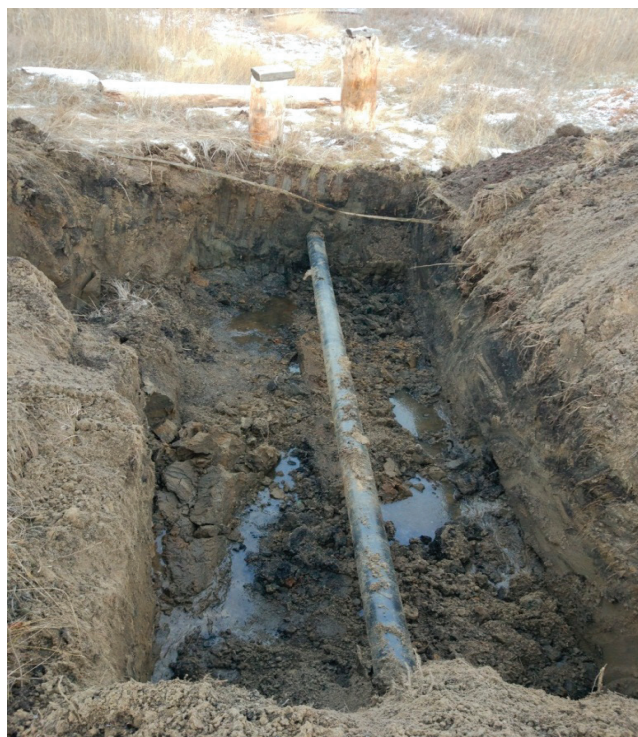
Рис. 1. Шурфовый осмотр участка
