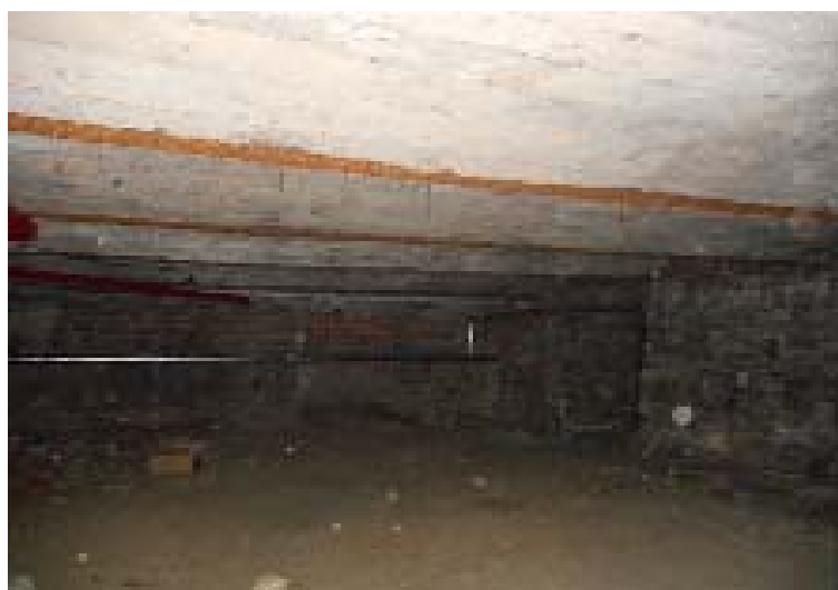
Рис. 4. Надподвальное перекрытие. Фрагмент
