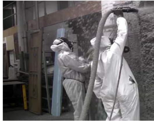
Рис. 6. Напыление эковаты
