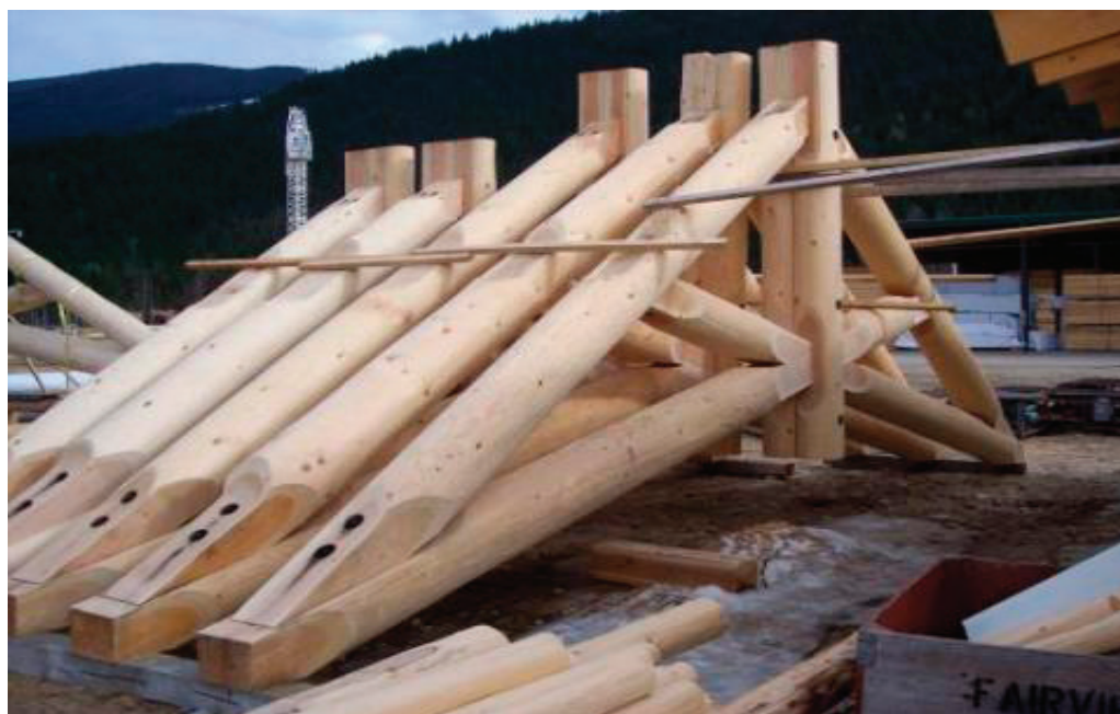
Рис. 2. Конструктивный элемент «Канадская ферма ножницы»
