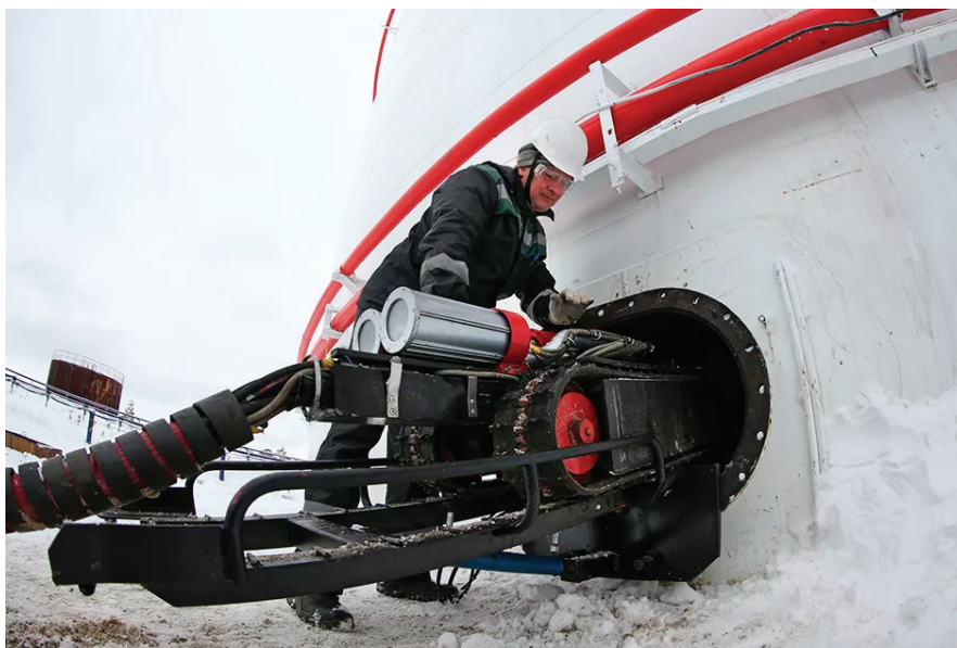
Рис. 4. Робот для механизированной очистки
