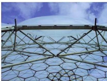
Рис. 4. Установленное покрытие купола
