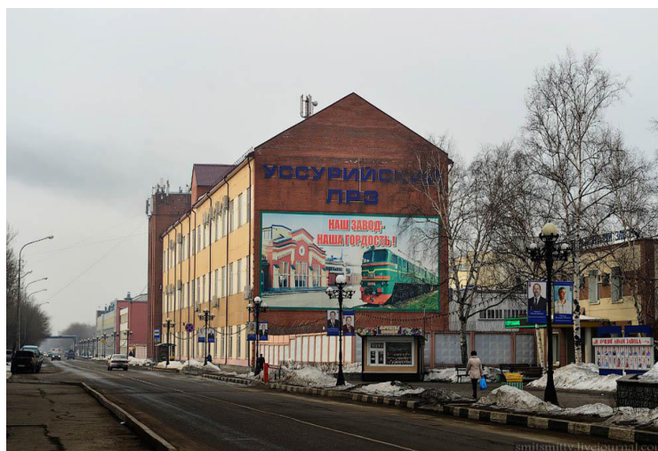
Рис. 2. Локомотиворемонтный завод. Уссурийск
