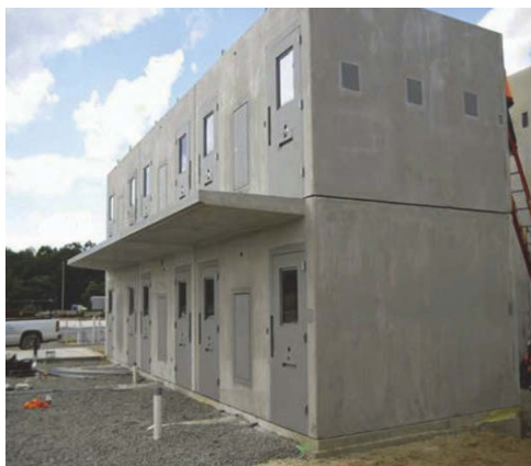
Рис. 4. Ячеистая система полносборного строительства
