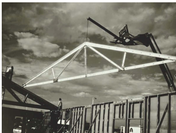
Рис. 2. Монтаж стропильной фермы
