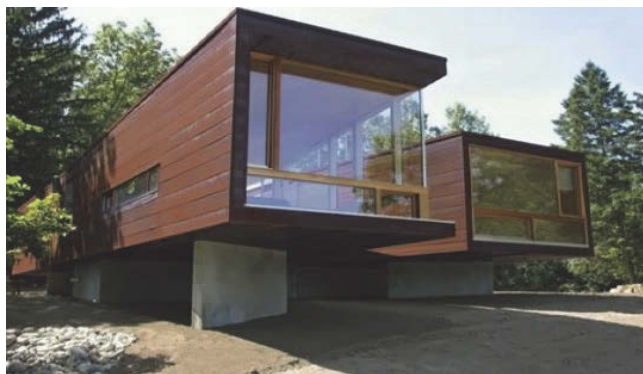
Рис. 1. Модульное полносборное здание
