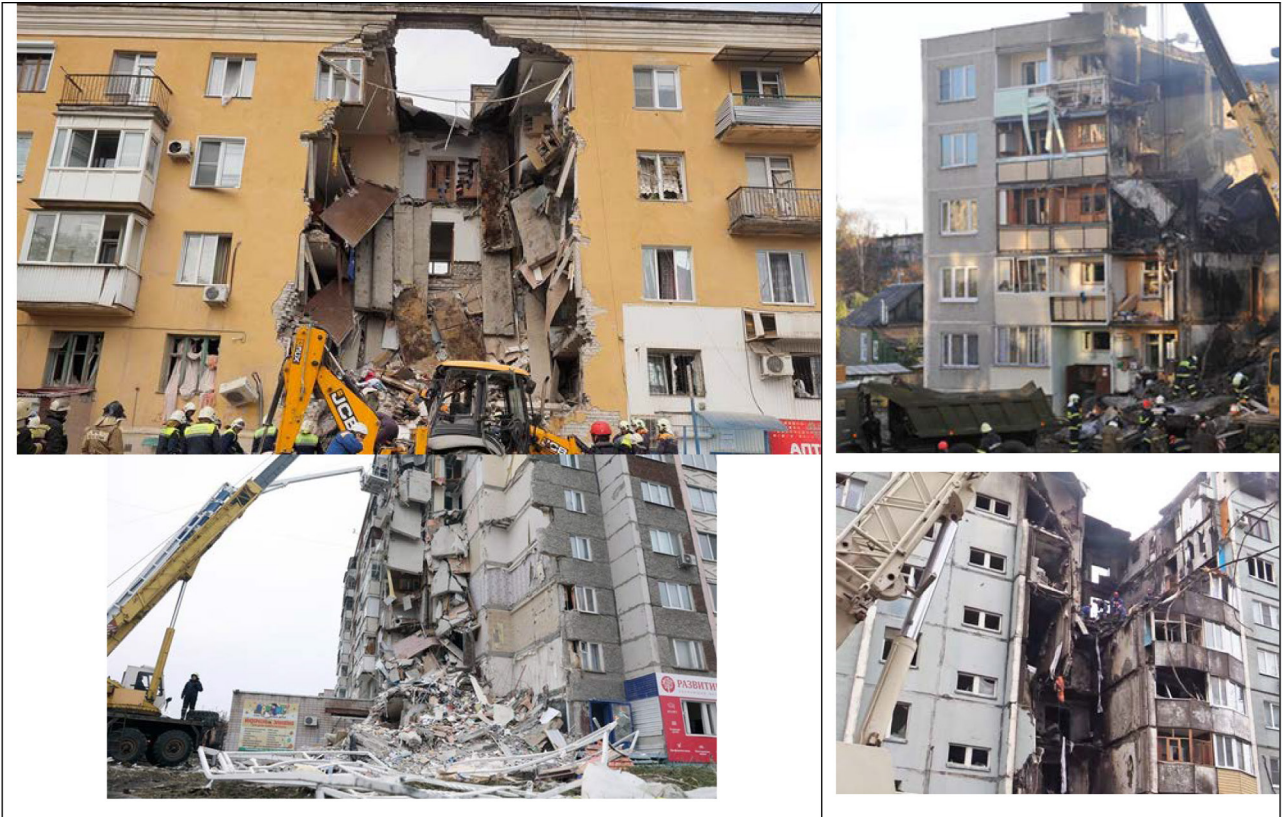
Рис. 3. Последствия взрывов природного газа в многоквартирных домах, произошедших на территории РФ за период 2012–2018 гг.
