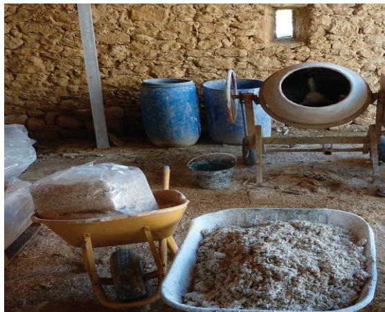
Рис. 1. Подготовка конопляного бетона
