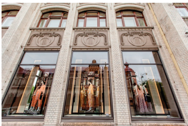
Рис. 5. Обновленный фасад здания ГУМа
