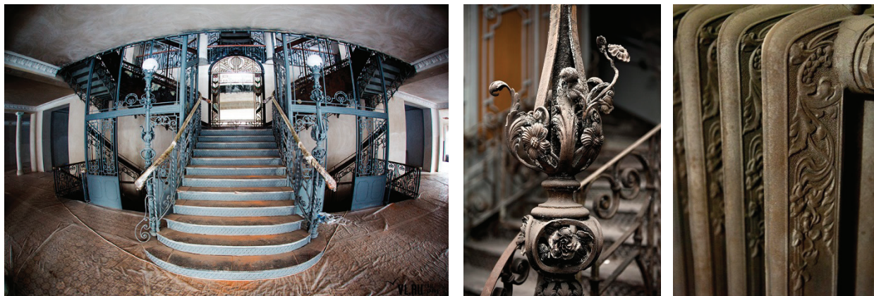
Рис. 4. Реставрационные работы лестниц, радиаторов отопления в здании Владивостокского ГУМа
