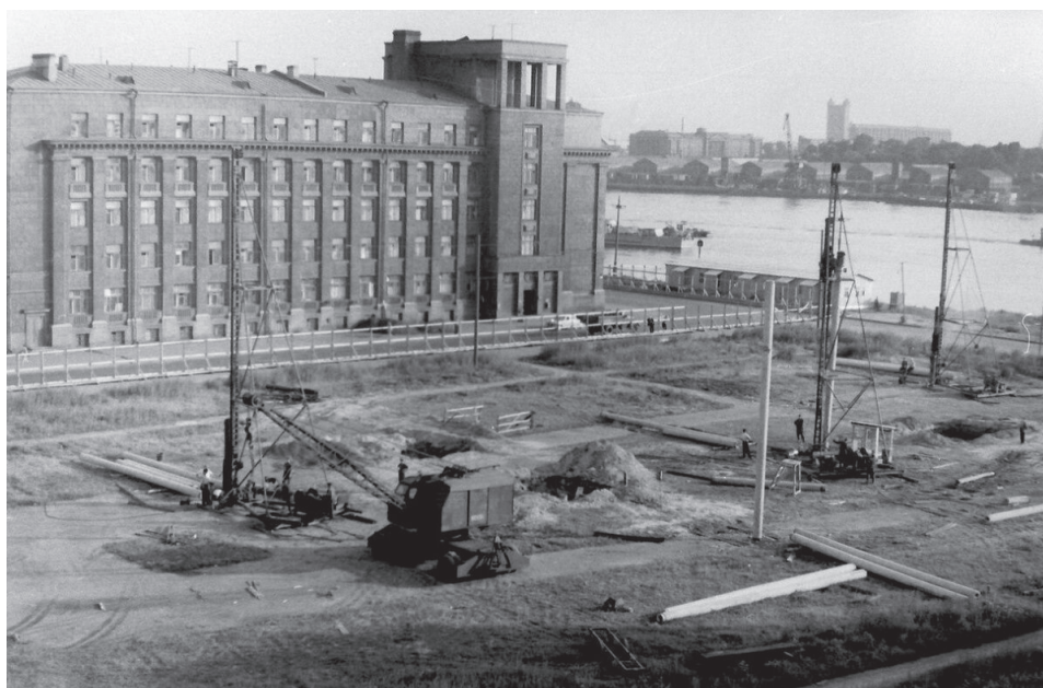
Рис. 1. Погружение забивных свай в Невском районе 1965 год
