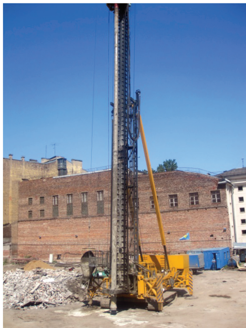
Рис. 2. Установка FUNDEX F-12 на объекте строительства (2006)
