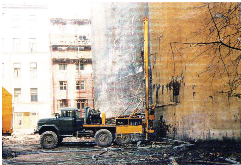
Рис. 4. Устройство свай в плотной городской застройке по технологии бурения с креплением стенок скважины глинистым (бентонитовым) или полимерным раствором
