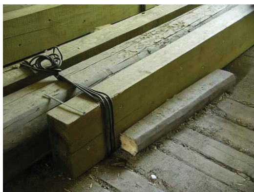
Рис. 1. Усиление балки деревянными накладками
